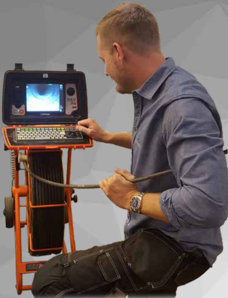
Steg 1: Granskning med inspektionskamera
