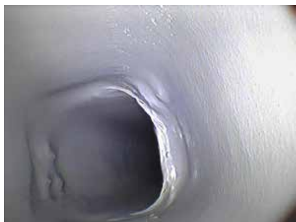
Eternitkanal efter tätning med Linervent
