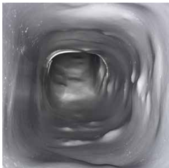
Tegelkanal efter tätning med Linervent
