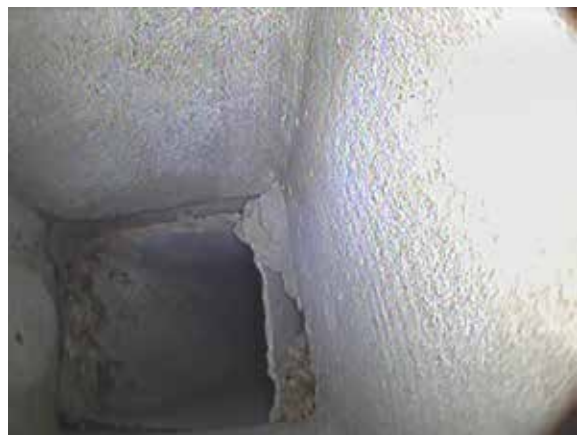
Eternitkanal före tätning
